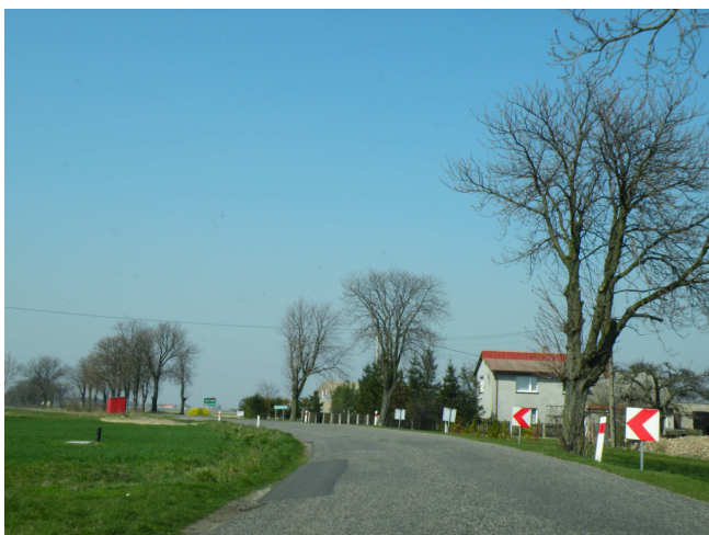
Droga powiatowa nr 2917P – Żydowo
