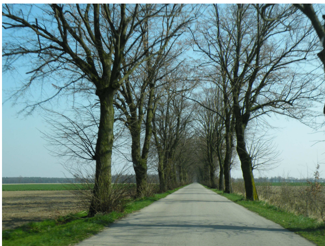
Droga powiatowa nr 2915P – Gorazdowo
