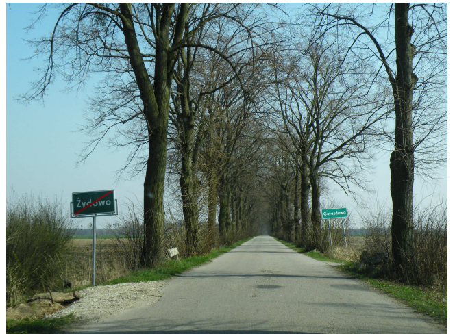
Droga powiatowa nr 2915P – Żydowo
